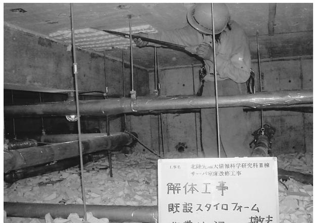
補強対象の既存仕上げ撤去作業(断熱材撤去)
