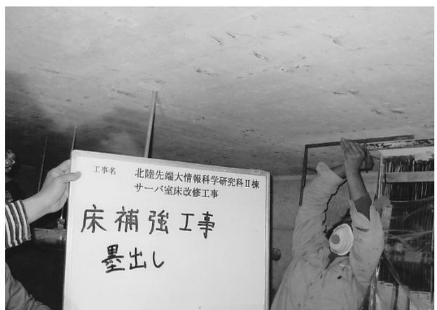
CFRP 帯板接着位置墨出し作業
