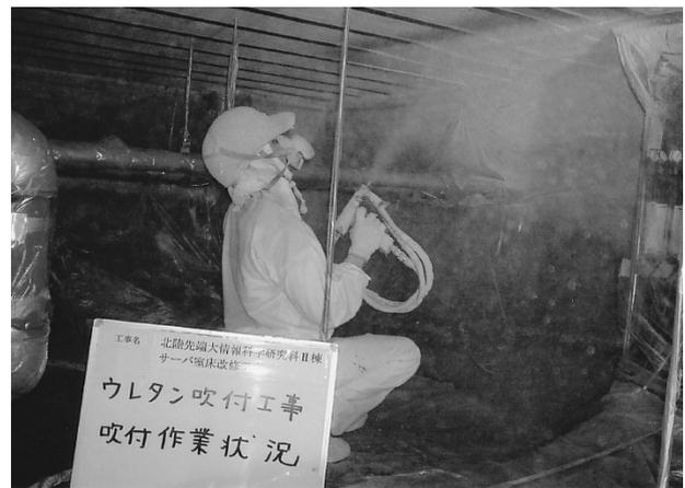
施工後の断熱材吹き付け作業
