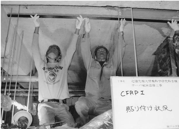
CFRP 帯板貼り付け作業
