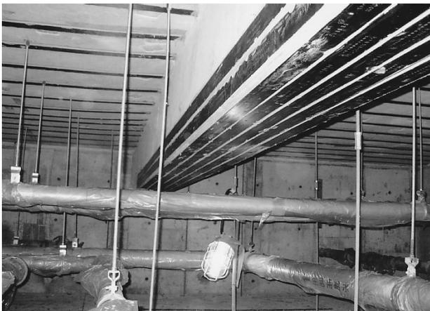
貼り付けられた CFRP 帯板
