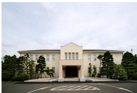
致遠館（旧本社事務所） （大同工業(株)提供）
