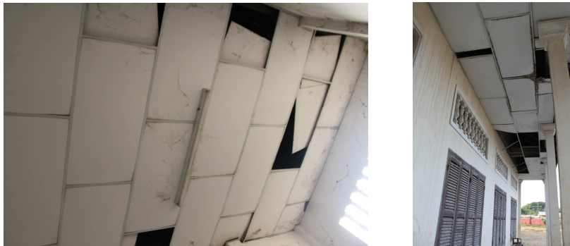
図21 建物内外の天井の様子
