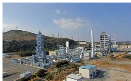
図 3 EAGLE パイロット試験設備外観
