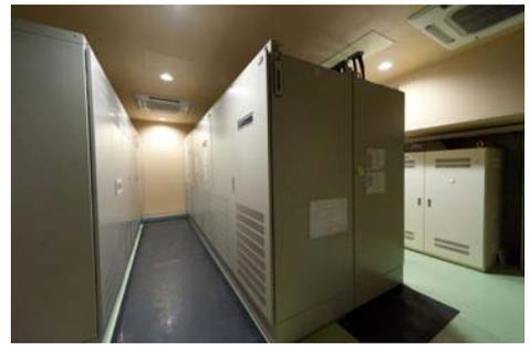
図4. UPS装置(200kVA x 3台)
