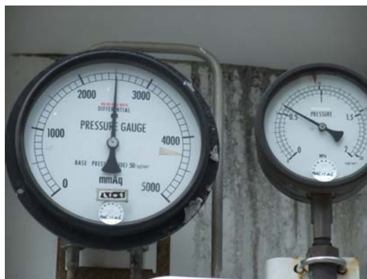
図 4. ガス取り用液体窒素貯槽に付属しているメータ。左が液量計、右は内圧計。液量計の単位は mmAq（水に換算して何 mm の高さ分の上下圧力差があるかを表示）である。
