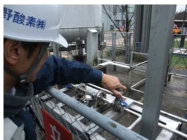
図 6. バルブ閉鎖作業
