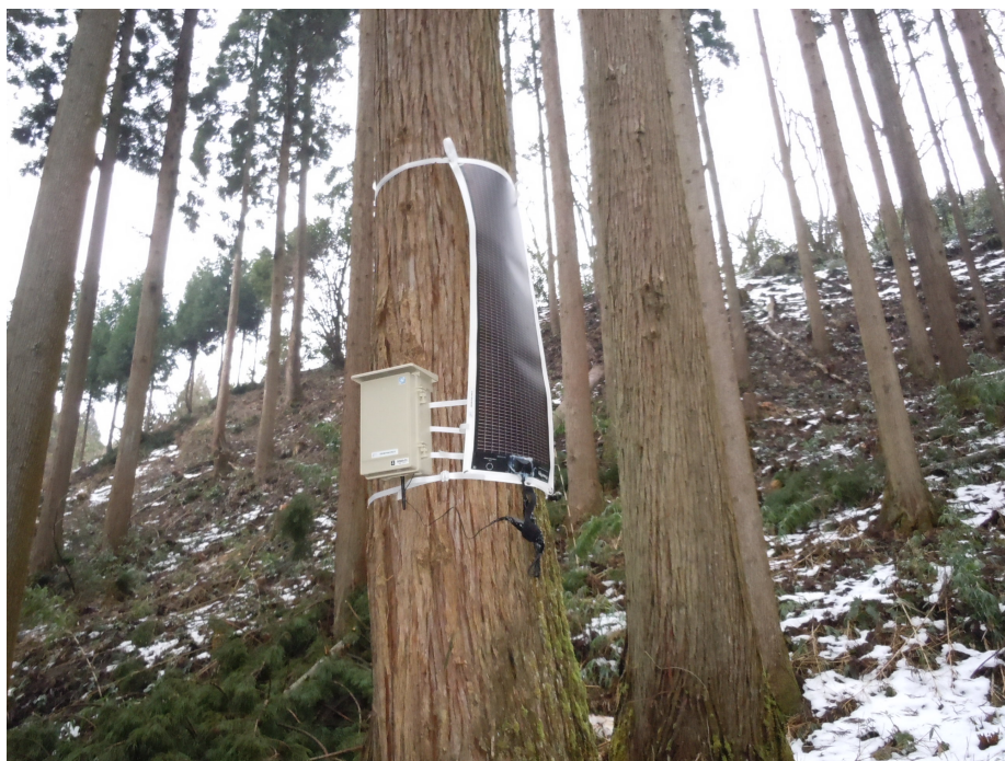
図 9.1: 岩本町内山林での機器設置風景
