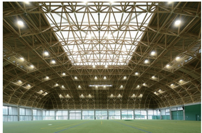
写真-12 高知県立室戸広域公園屋内運動施設/室戸ドーム
