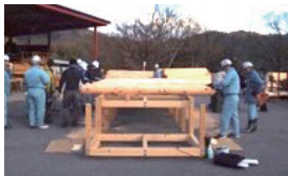
写真-9 丸棒加工と部材組み立てのトレーニング風景
