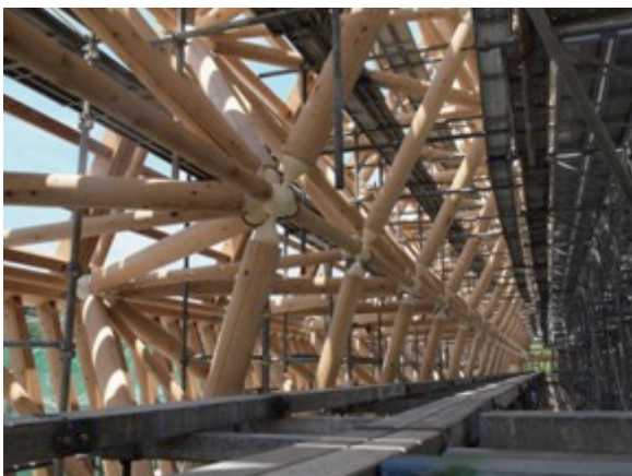
写真-13 トラスの立ち上がり部
