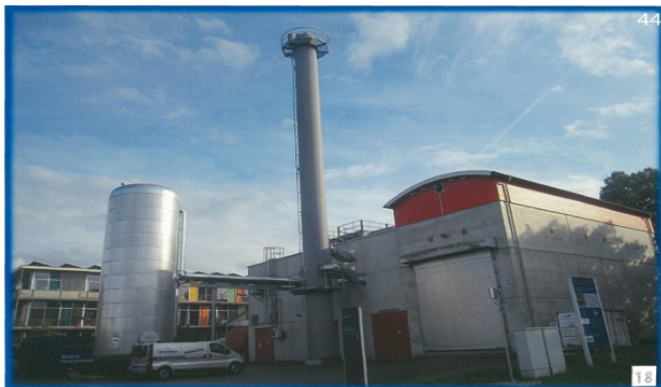
図 4 フライブルグ市のコージェネ発電所 （燃料：木質チップ、電気と温水を併給する）
