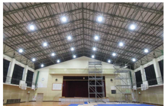
中学校体育館へのLED照明導入
