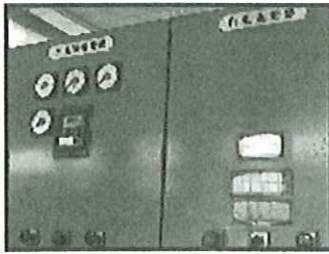
ポンプの電気を調節する配電盤
