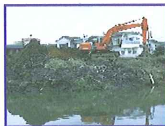
川を広げる工事
