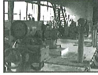
水道水を送るポンプが並んだ様子
