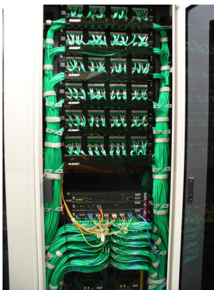
図 6.6: 実験用スイッチ B1 (Cisco Catalyst 6009)
