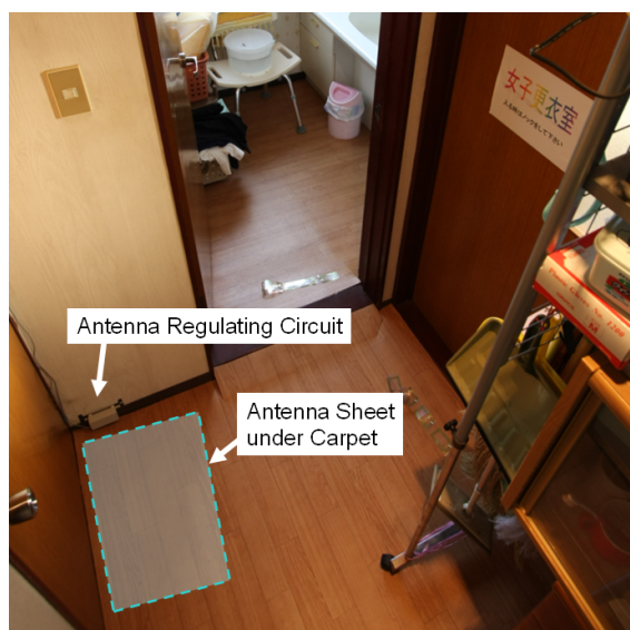
図5 リーダアンテナ設置の様子(トイレ前、図4における2番のリーダに対応)
