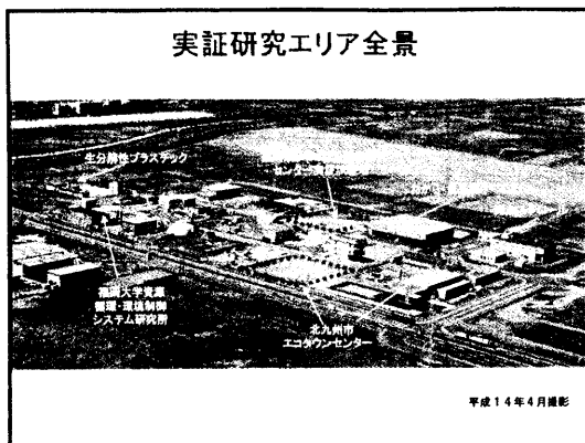
図2 実証研究エリア全景
