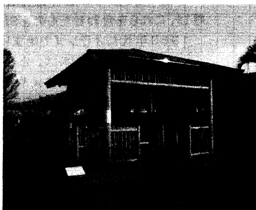
高耐久木材を用いた評価試験用東屋
