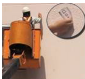
現行の点検作業 円内はクラックゲージ
