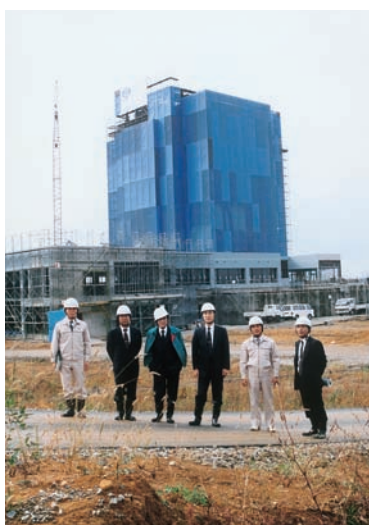
研究棟建設状況（平成3年10月）
