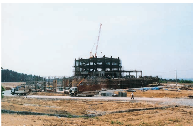
研究棟建設状況（平成3年6月）
