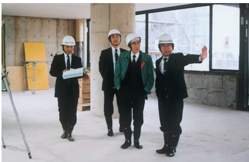
講義棟建設状況（平成3年10月）
