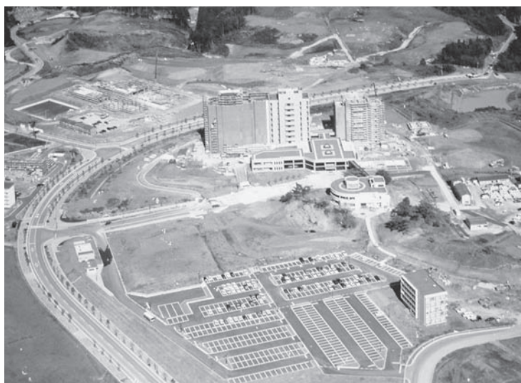
私が着任して7ヵ月後の平成4年10月の写真。約1ヵ月1フロアのペースで進んだ材料科学研究科I棟（7階建て）の建設は、ほぼ外観は完成し、情報科学研究科II棟の骨組みの建設が進んでいる。
