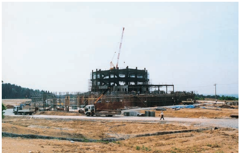
研究棟建設状況(平成3年6月)
