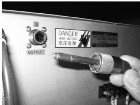
ケーブルはこのシャシーメーカー、「松定プレジジョン」のオリジナル端子。ケーブル自体が装置の下を通っているため、ケーブルの交換は不可。高圧ゆえケーブルの改造も不可。よって同じメーカーから継続購入しかできず、そのまま購入した。
