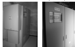
瞬時低電圧補償装置(MS棟, 知識棟)
