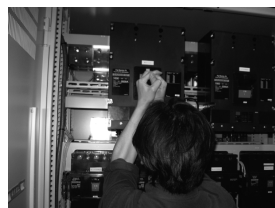
無停電電源装置(情報棟)
