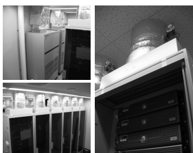
エアコン冷気を直接ラック内へ
