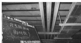
床下に炭素繊維板を貼付鉄筋の増量
