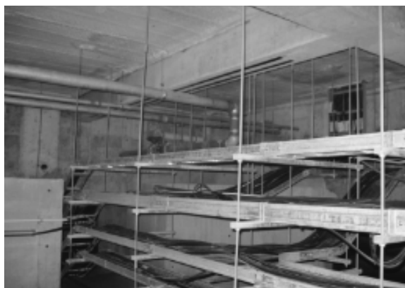
下階にパイピング - 制約が多い
