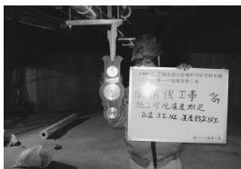
施工環境の確認
