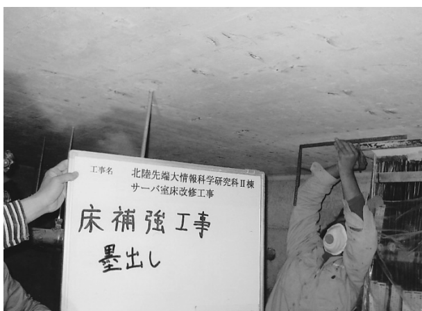
CFRP 帯板接着位置墨出し作業
