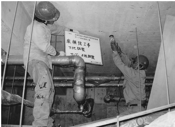
コンクリート躯体部分の研磨作業
