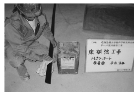
CFRP 帯板の清掃
