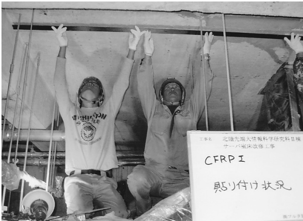
CFRP 帯板貼り付け作業
