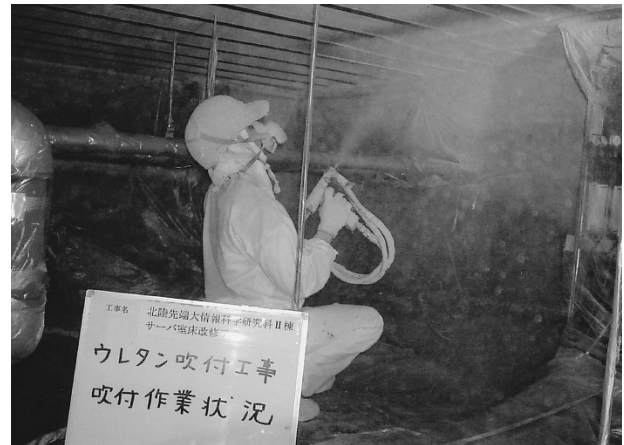
施工後の断熱材吹き付け作業
