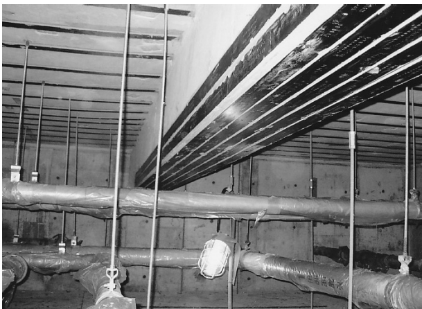
貼り付けられた CFRP 帯板
