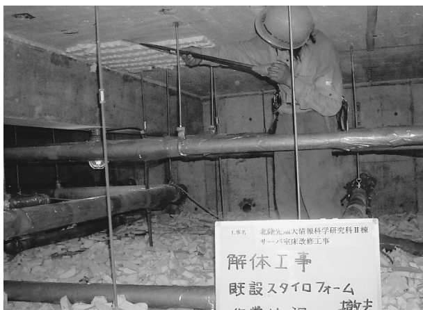
補強対象の既存仕上げ撤去作業(断熱材撤去)
